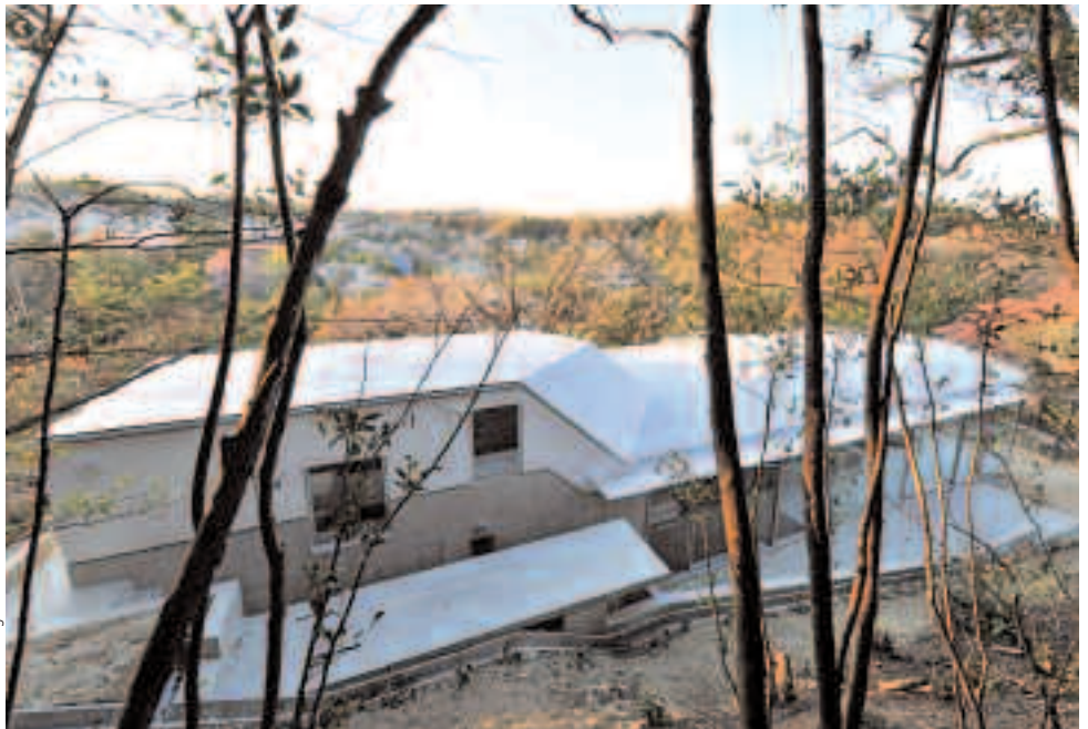
∨ Vue de la façade arrière : le volume de la maison encastré dans la pente.
