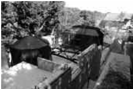
∨ La maison en construction : les volumes porteurs en tôle d'acier brut et la résille structurelle de la toiture.
