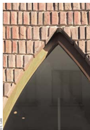
Détail du calepinage de la brique autour d'une fenêtre en ogive.
