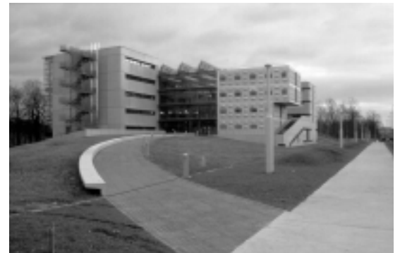
L'accès au bâtiment, dans la Cité Descartes, à Marne-la-Vallée.
