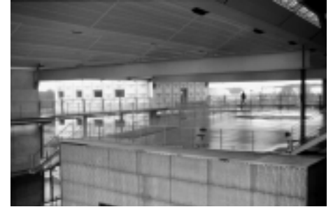
Sous l'auditorium, dans les coursives, sur l'auditorium.
